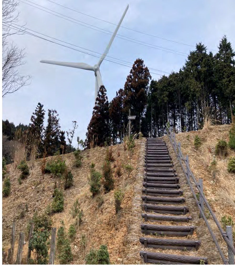
< 既存遊歩道の整備例 >
