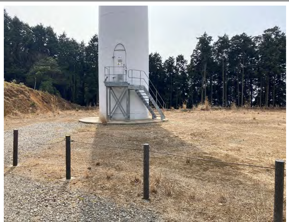
<代替遊歩道の施工例>
