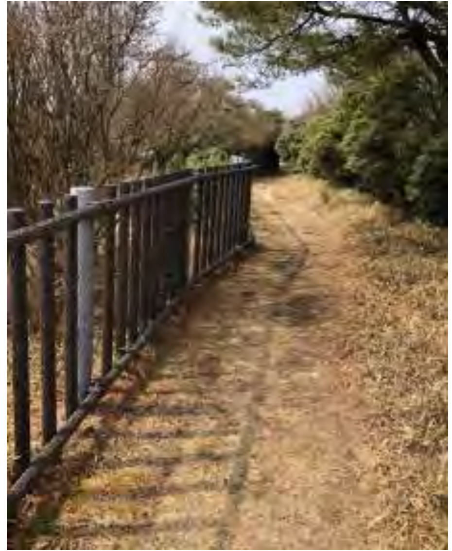
< 既存遊歩道の整備例 >
