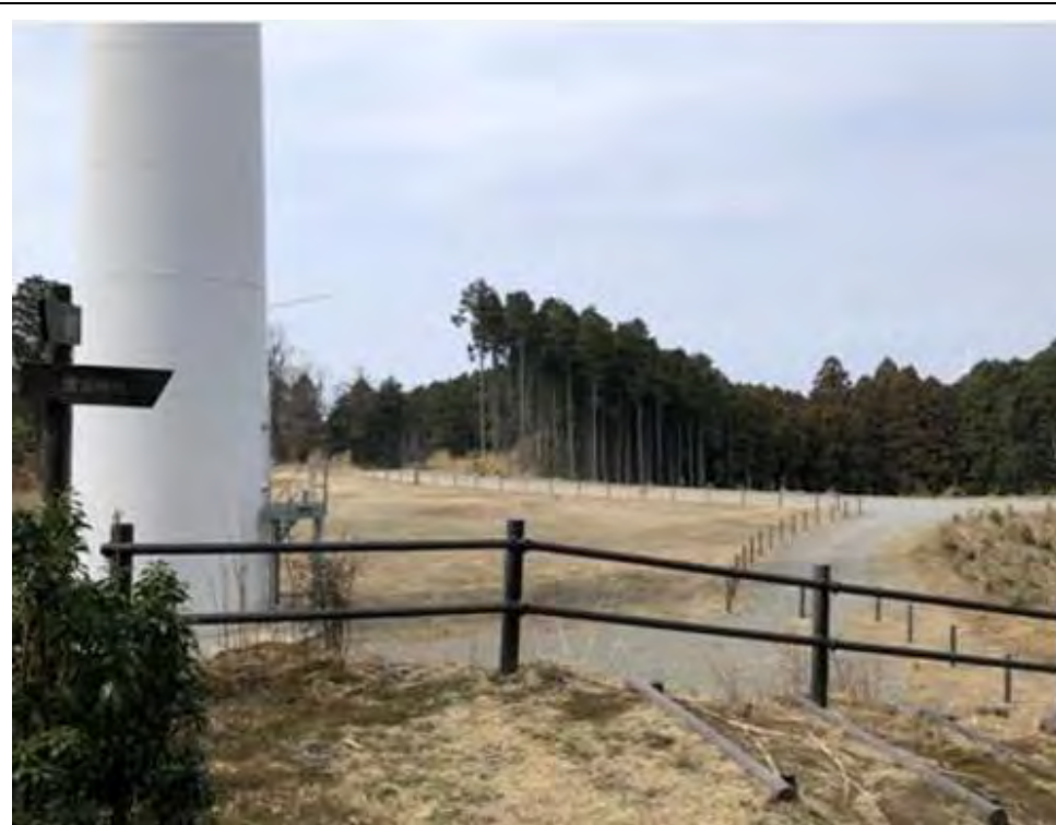
<代替遊歩道の施工例>
