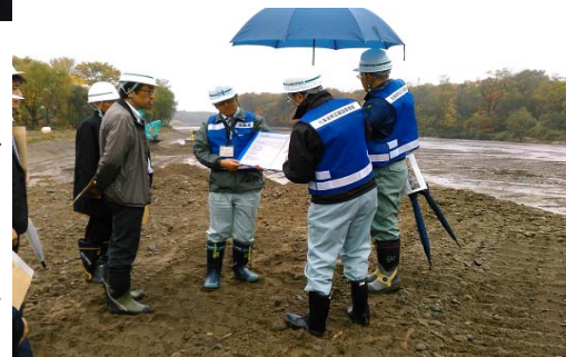
芽室川災害復旧現場（帯広建設管理部）
