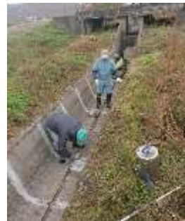
水路の目地補修
