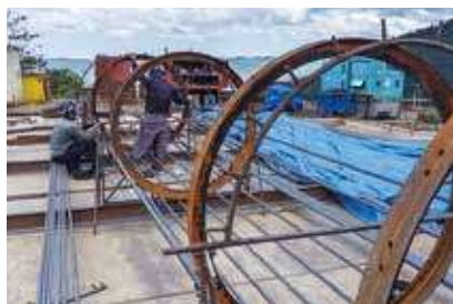
▲場所打ち杭補強リング
