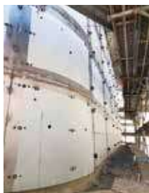
▲橋脚耐震補強巻き立て鋼板
