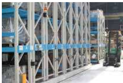
▲立体倉庫管理システム
