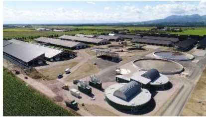
バイオガスプラント
