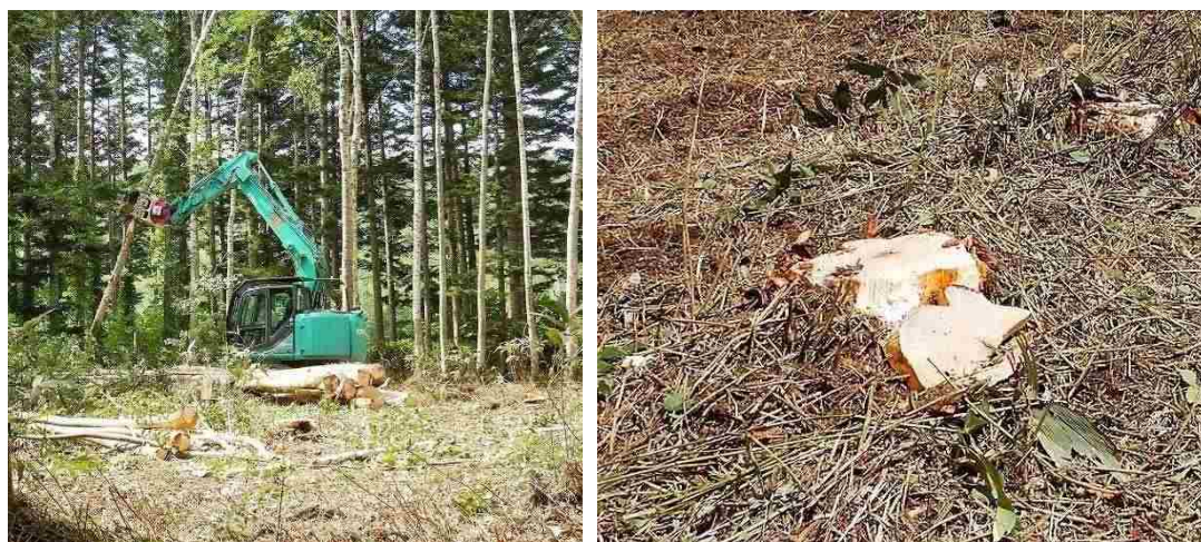
写真 3.13 フェラバンチャによる伐木と集材作業の効率を上げた地際伐木
