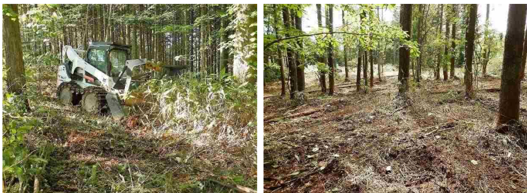
写真 3.12 伐木前の林業用クラッシャーによる全面ササ刈と仕上がり
