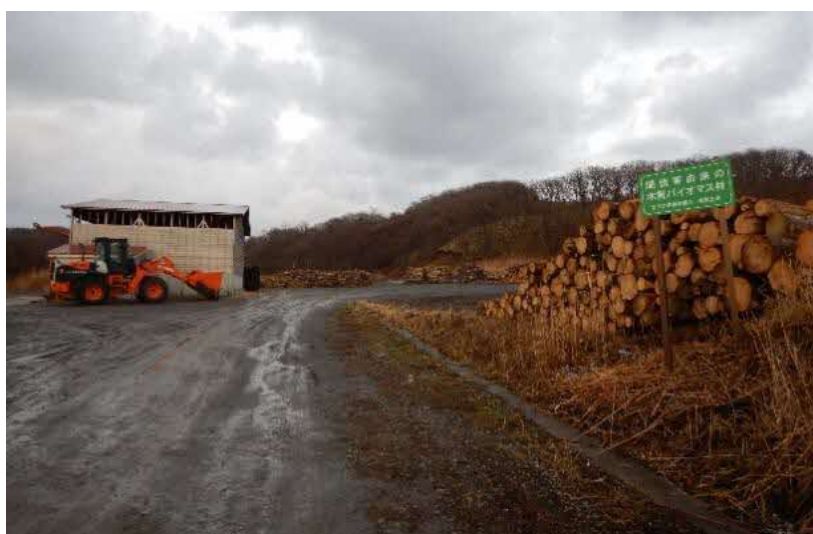
写真 3.52 第2生産施設の全景
