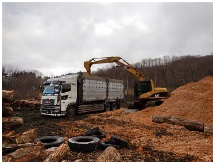
写真 3.30 バックホウ (312C) を用いてファームダンプ (52 m 3 積載可能) に積込
