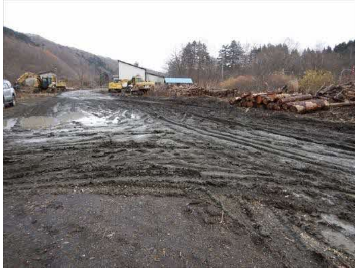
写真 3.27 中間土場内は舗装等をしていない
