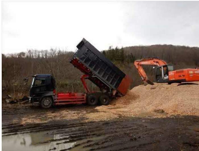
写真 3.28 木くず燃料の荷下ろし
