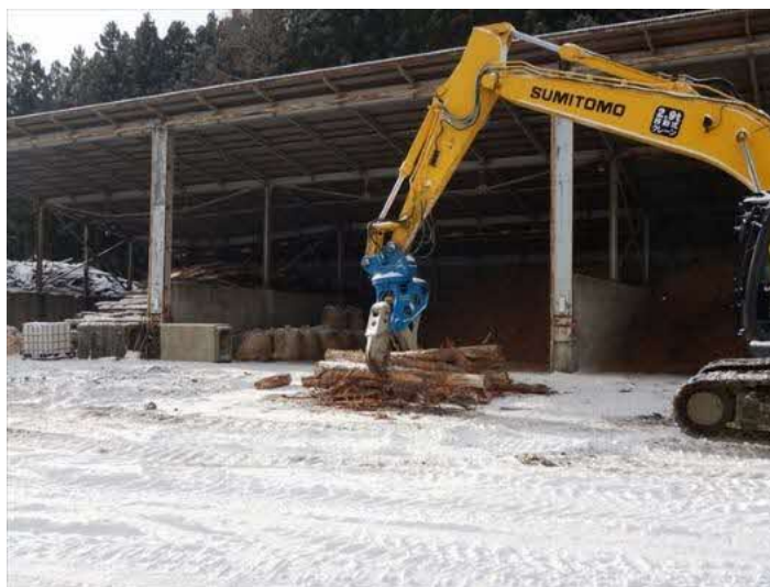
写真 3.12 未利用材を一次破碎（SH200 使用）
