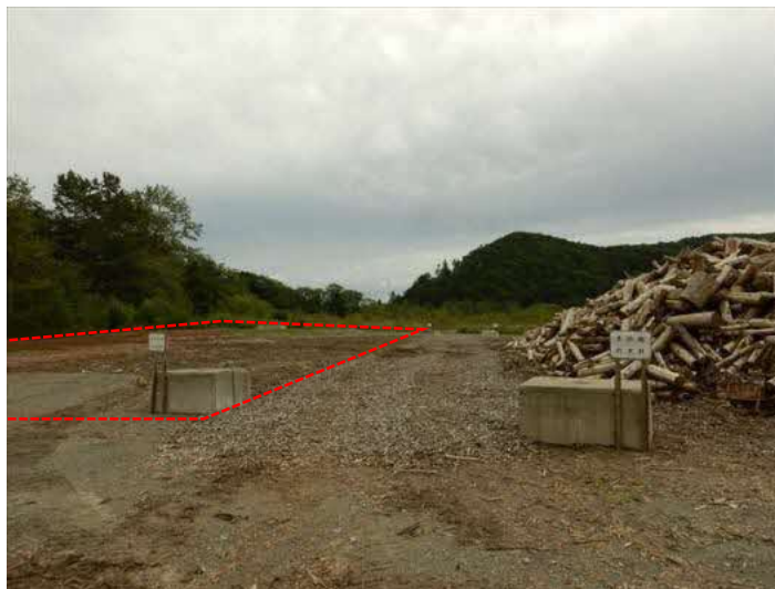
写真 3.9 整備済みの中間土場（実証では写真左側のスペースを使用）
