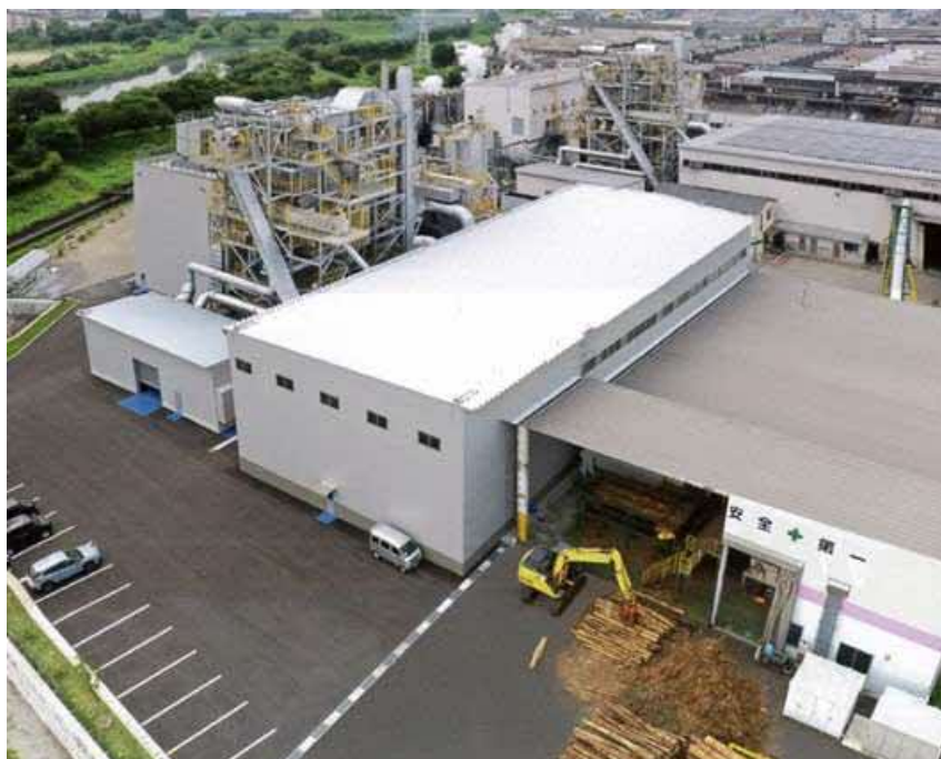
図 61 岐阜バイオマスパワー外観
