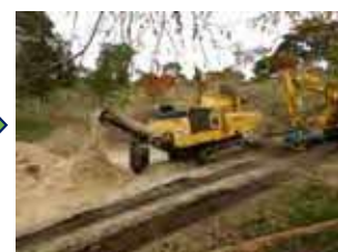
【発電所】 自社チップパー機でチップ 加工し、燃料として利用
