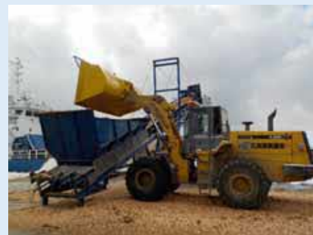
運搬船への積込作業
