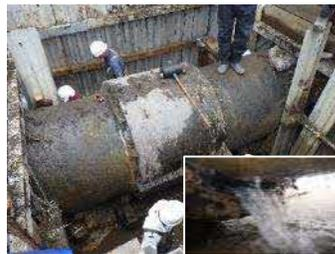
北海道胆振東部地震に伴う漏水
