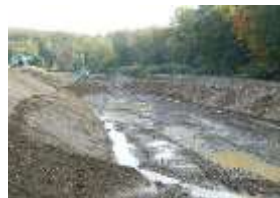
河道掘削状況
