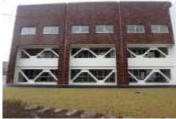
函館市民会館の耐震化（函館市）
