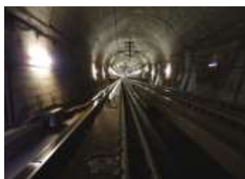
青函トンネル (三線式軌道)
