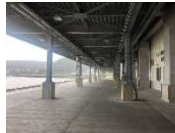
漁港整備(えりも町)
