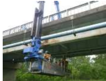
橋梁点検状況
