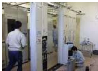
通信機器の点検作業
