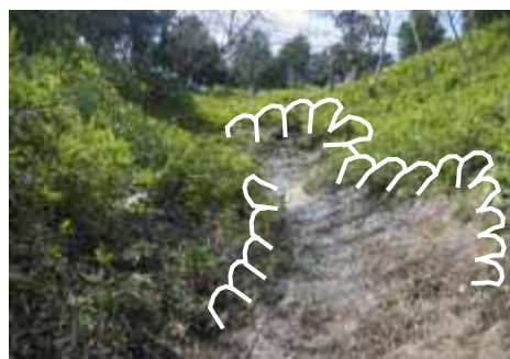
荒廃斜面对策着手前
