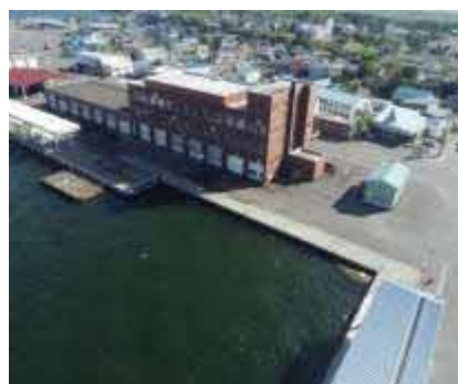
-3.5m岸壁着手前
