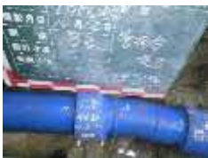
耐震管へ改修
