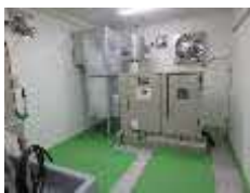
非常用発電機の設置
