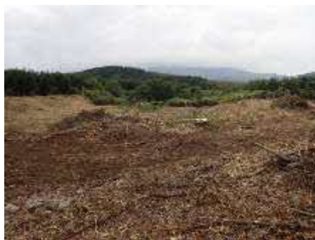
砂防堰堤工着手前
