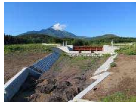
砂防堰堤工完了
