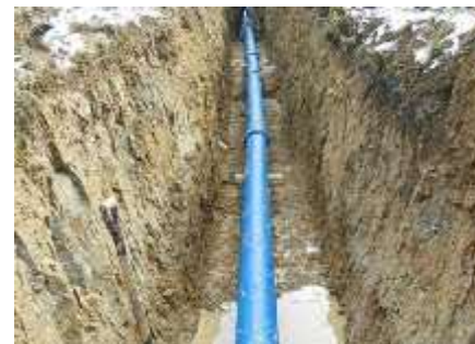
整備後(耐震化された管路)
