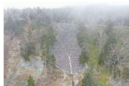
法枠工による斜面对策完了
