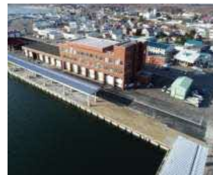
-3.5m岸壁完了
