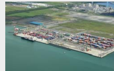
国際海上コンテナターミナル (苫小牧港東港)
