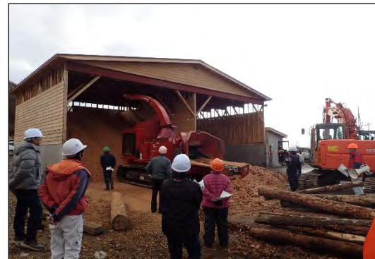
木質バイオマス用チップ生産施設
