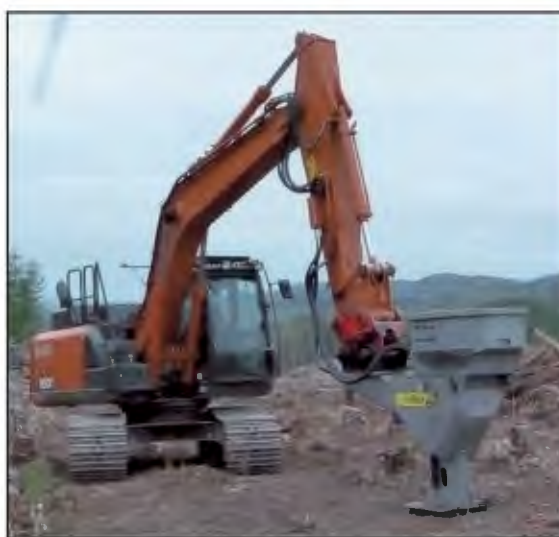
(機械によるコンテナ苗植栽)
