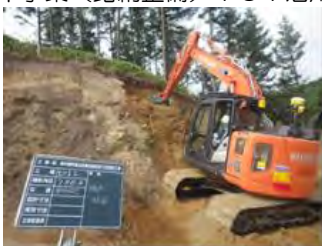
マシンガイダンスバックホウによる法面掘削
