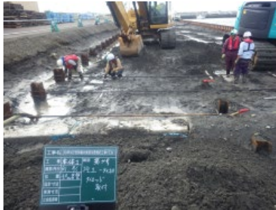
復旧工事の実施（タイ材取付 及び コンクリート舗装）
