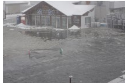
背後家屋被害状況
