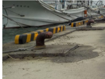
復旧前（岸壁の被災状況）
