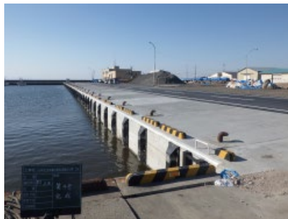
復旧工事の実施（タイ材取付 及び コンクリート舗装）
