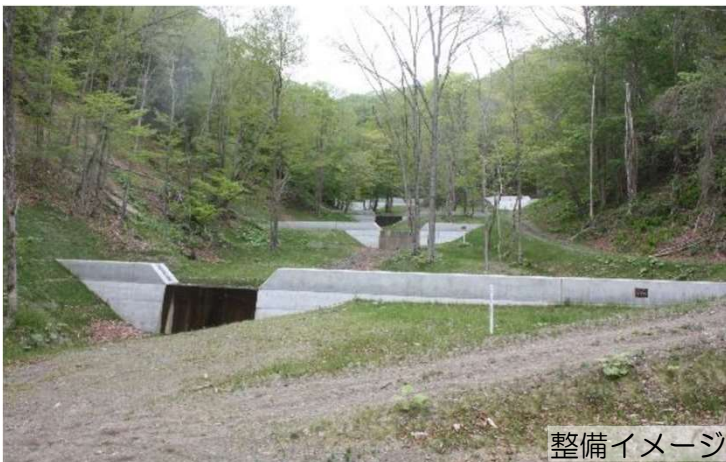
民有林内における治山ダムの整備
