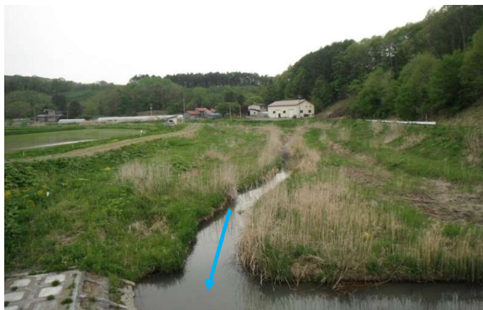
（ウクル川）河道掘削等の実施
