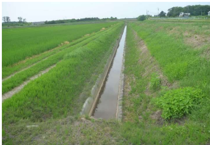
農業排水路の整備
