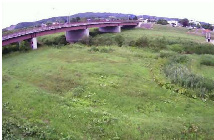
（厚真川）簡易型河川監視カメラによる映像提供
