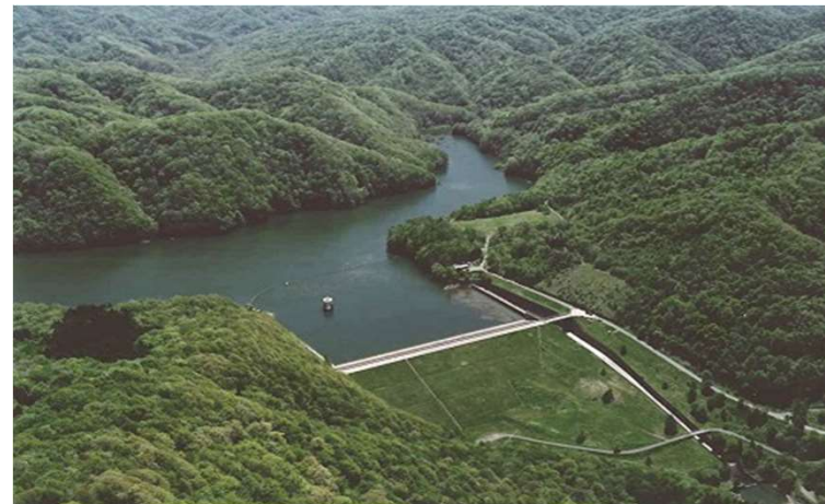
厚真ダム (室蘭開発建設部、厚真町土地改良区)
