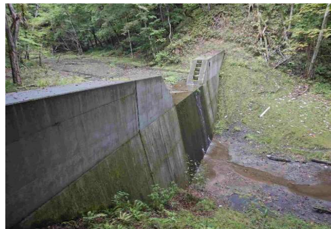
道有林内における治山ダムの整備
