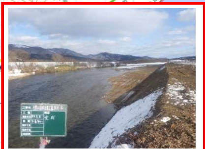
河道掘削・樹木伐採
