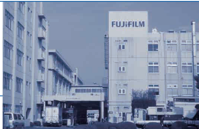
工場棟の全景。
