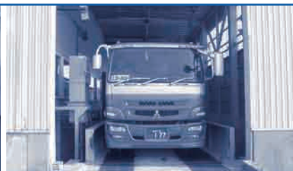
トラックスケール。
