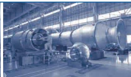
大型ポンプ組立職場。
