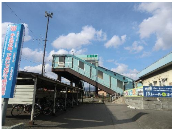
七重浜駅(外壁、屋根)
