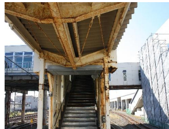
木古内駅ホーム上屋(屋根、柱)
