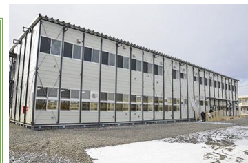
早来中学校仮設校舎(安平町)
