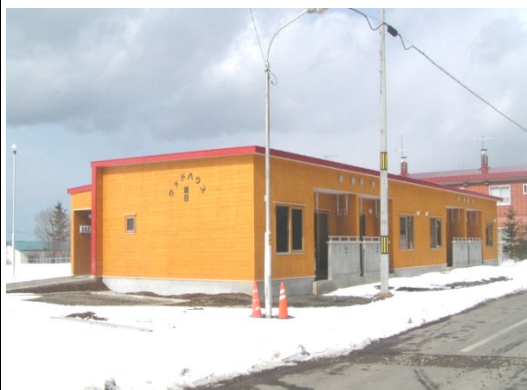
木造公共施設（共同住宅）
