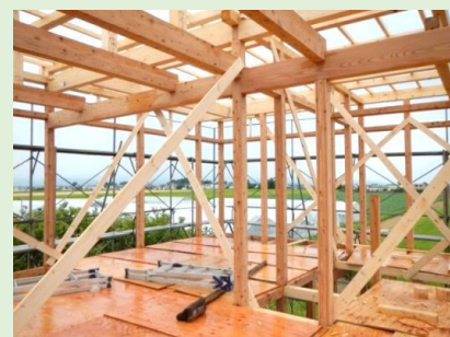
コアドライを使用した建築中の住宅
