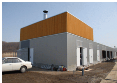
～エネルギー棟～
