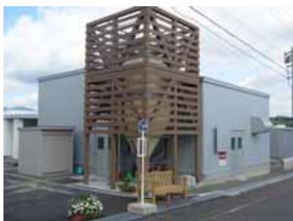
～ ボイラー室外観と燃料タンク～
