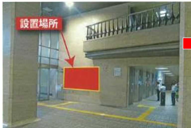
● 本庁舎1階ロビー 東玄関側壁面
