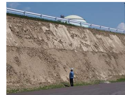
防潮堤（盛土区間）
