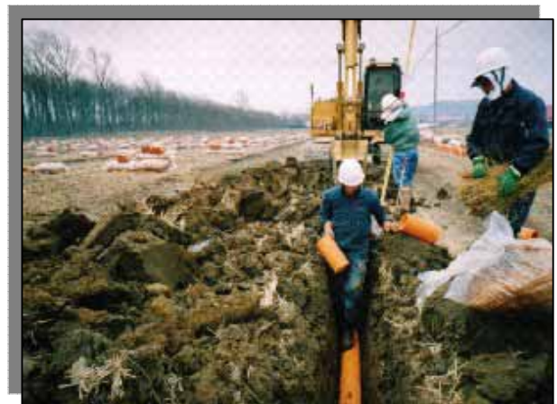
暗きょ排水の施工のようす
