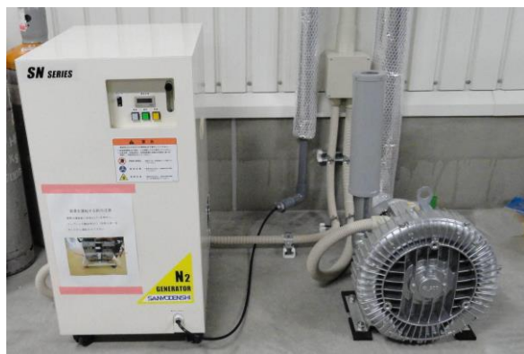
窒素封入設備
