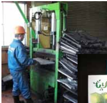
ラジエーターの コアの取り外し
