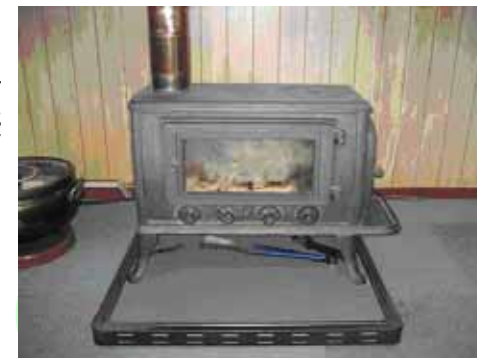
本社事務所にて薪ストーブの設置
