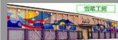
米穀雪零温貯蔵施設「雪蔵工房」外観
