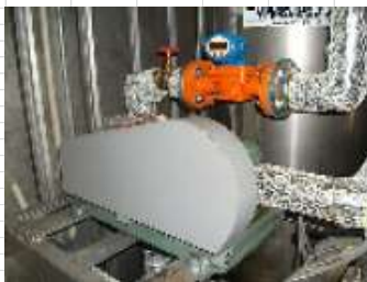
㉓「ラインフィルター」 固形物を除去する。
