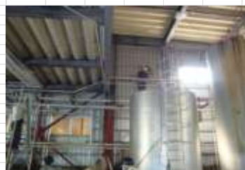
⑩「魚油タンク」 分離した魚油を貯蔵する。
