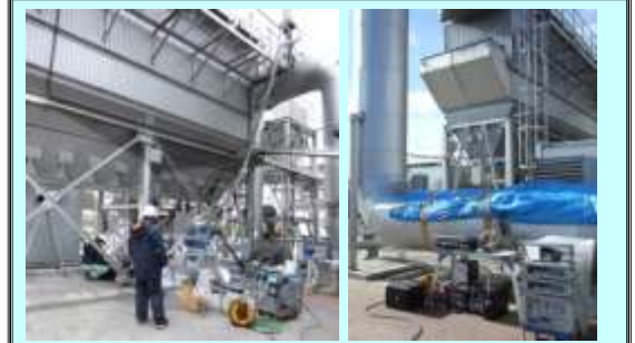
消石灰吹込みと燃焼排ガス成分の計測
