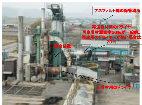
図9 アスファルトプラント(Ⅲ型)全景
