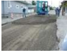
下層路盤2層目敷き均し後
