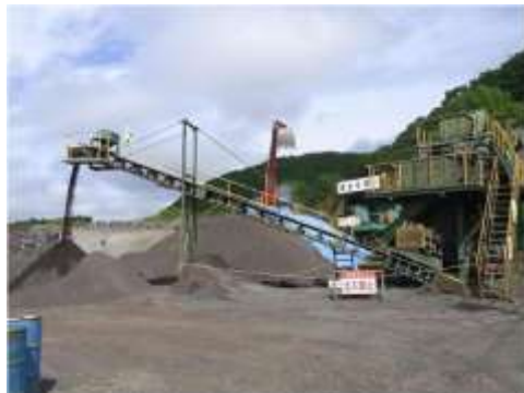
図7 再生骨材の製造(破碎装置)
