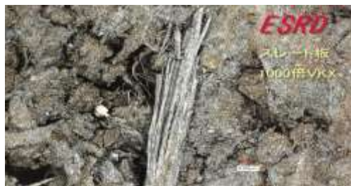
スレート板・クリソタイル 風化・劣化 状況
