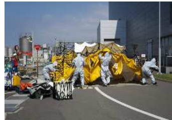
訓練の様子 2 PCB 除染テント設置
