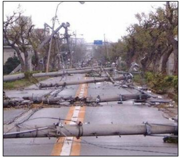
[台風による電柱の倒壊]
