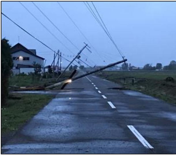
[台風による電柱の倒壊]
