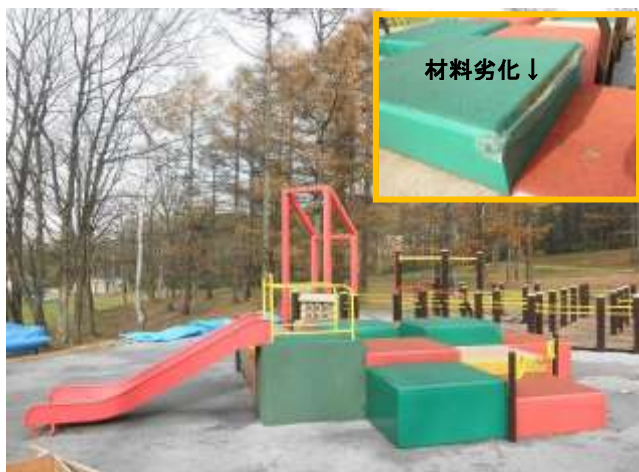
【北海道子どもの国】材料が劣化した遊戯施設
