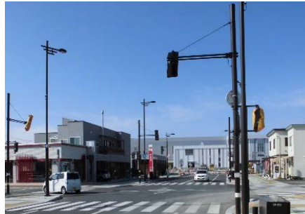
整備後（木古内町駅前通り）
