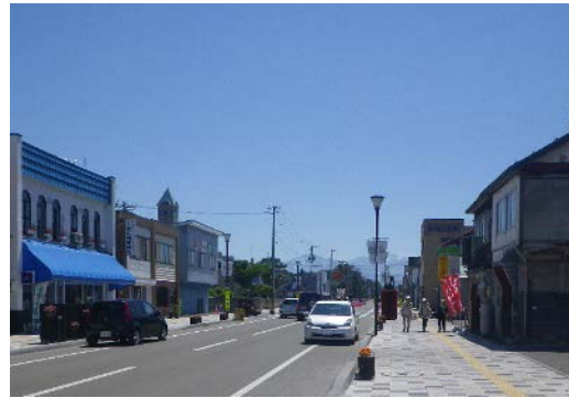
施工後 美瑛町（丸山通）
