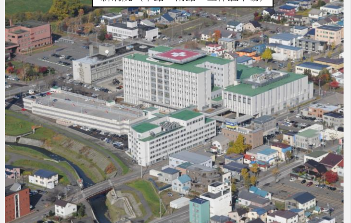
新病院 (本館・南館・立体駐車場)
