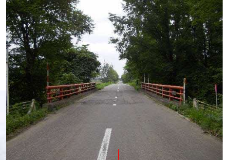
第1号橋現況写真
