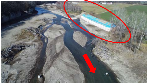
○復旧工事着手前(応急工事で土のうシート設置済)
