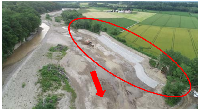
○復旧工事完成
