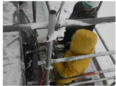
施工中の様子
