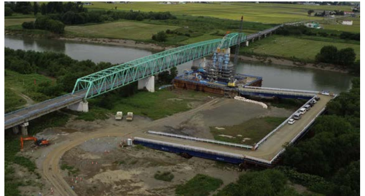
平成30年9月 現場状況
