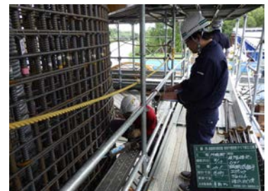
現場確認状況
