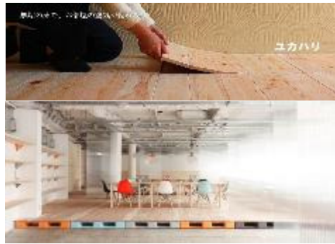
上：【写真4】床張りタイル 下：【写真5】工業用パレットの上に木を敷く 内装のオフィスビル
