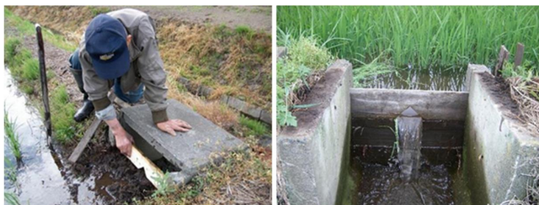
調整板設置状況
