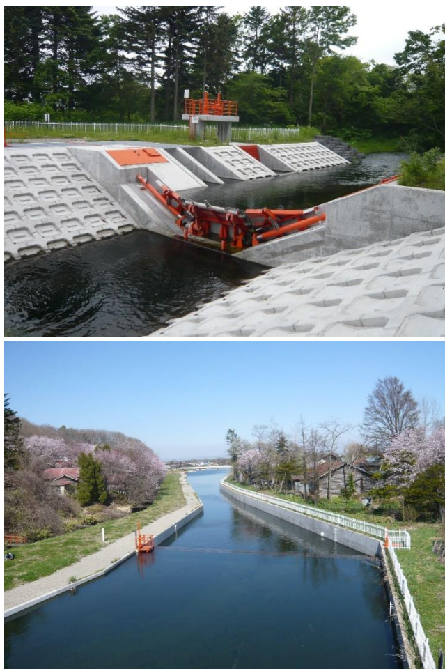
写真 7-1 恵庭市の温水ため池（上写真：取水口、下写真：ため池部）
